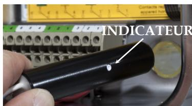
❹ Introduisez la nouvelle ampoule magnétique dans son logement et poussez-la en butée au fond. Veillez à ce que l'indicateur blanc soit visible à travers le trou de la vis de blocage.
